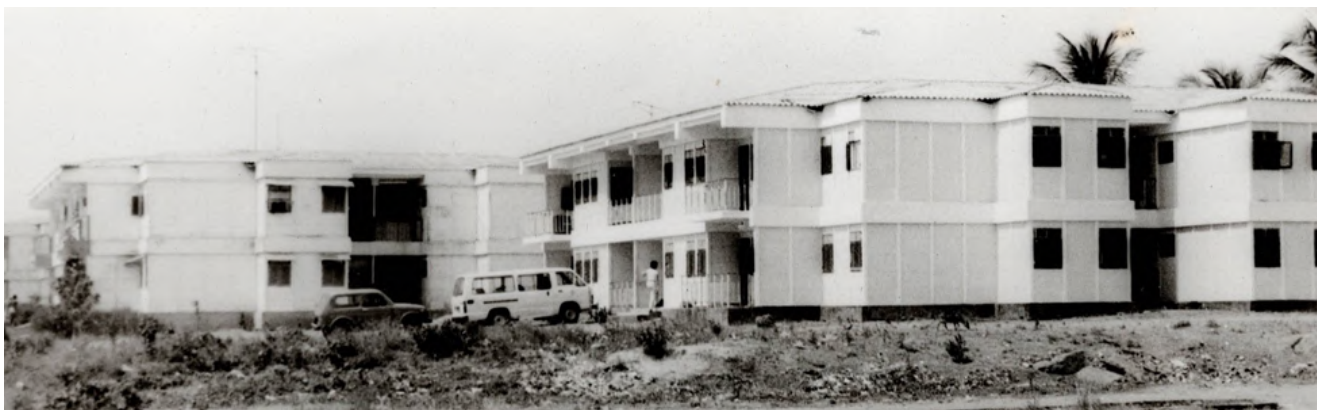
Fig. 02 – Blocos de apartamentos para quadros nacionais realizados com o sistema de pré-fabricação “Sandino”, Bairro d’Ajuda, Bissau (1978). Fonte: Coleção privada de Milanka Lima Gomes
