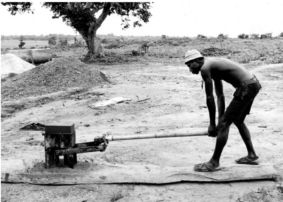
Fig. 04. Produção de blocos de terra estabilizada “nô cumpu”, Bairro-piloto de trabalhadores em Brá, Bissau (1978). Fonte: Coleção privada de Milanka Lima Gomes
