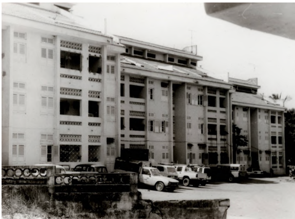
Fig. 05. Edifícios de apartamentos dos quadros nacionais, projecto do arquitecto sérvio Nikola Arsenić com financiamento da cooperação sueca, Bissau (1979). Fonte: Coleção privada de Milanka Lima Gomes.
