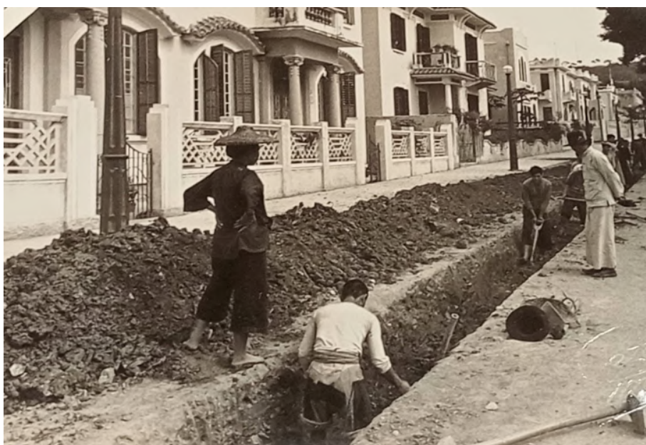
Fig. 01. Construção de infra-estruturas na Rua Conselheiro Horta e Costa. Fonte: (Gastão Borges, Repartição Técnica de Obras Publicas de Macau, Relatório do ano de 1940 , p. 138, AHU: OP01964/Photo)
