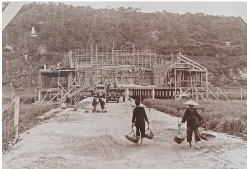
Fig. 02. Hangar em construção com trabalhadores chineses em primeiro plano e ao fundo o tecnico com chapéu colonial. Quarta imagem da sequência referida no texto. Fonte: (José Rodrigues Moutinho, Repartição Técnica de Obras Publicas de Macau, Relatório do ano de 1939 AHU: OP01963/Photo)
